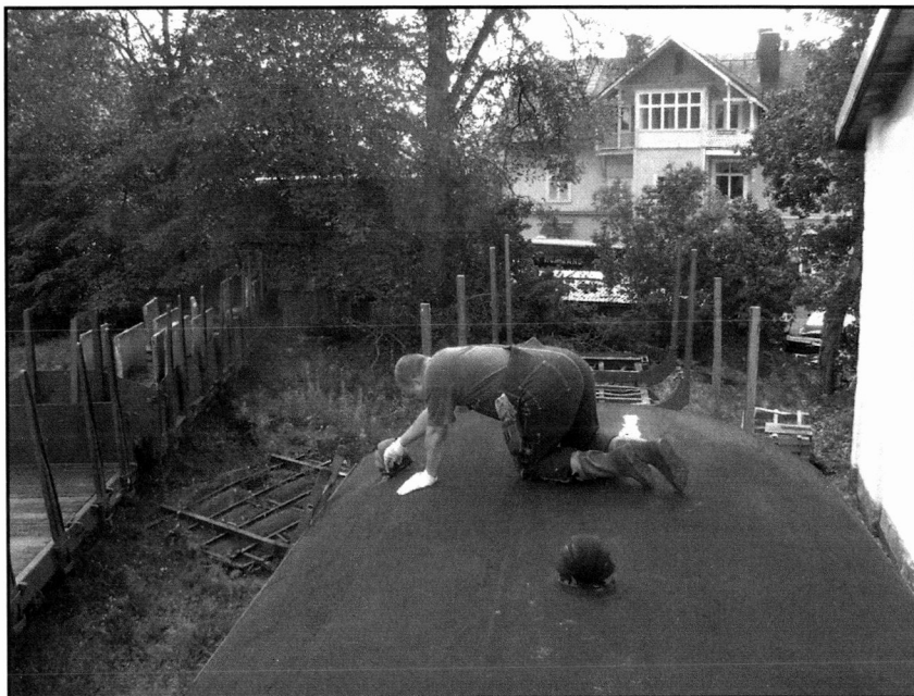
Ett tidigare takarbete på C4 11. Dan i arbete 2004-08-27. Foto Jan O.
