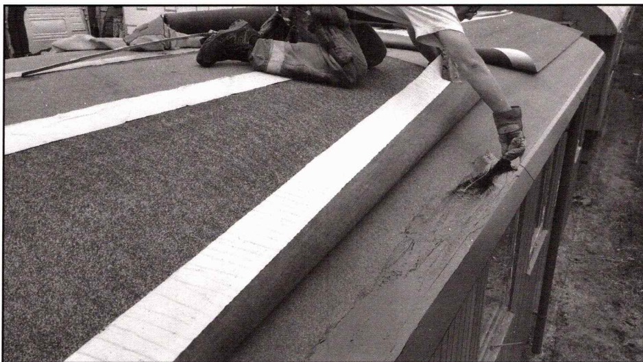
Martin klistrar nedre våden mot underlagspapp och takfotsplåt. Foto Dan C.
