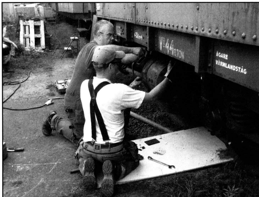
Dan och Martin jobbar med sidogeneratoren på Co8cs.
