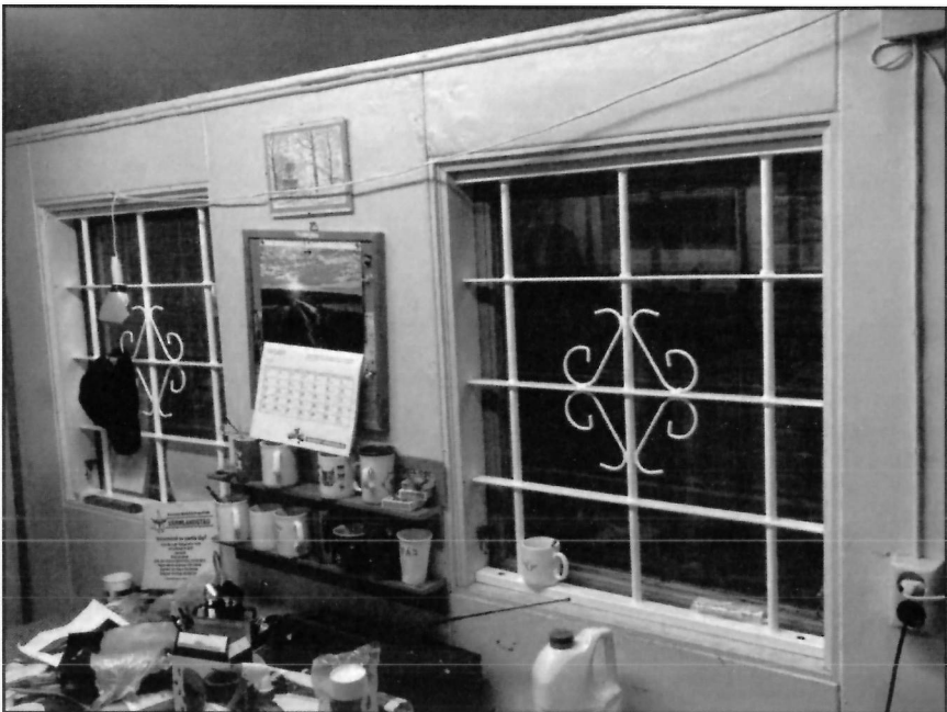
Nya fönstergaller i C4 11.
