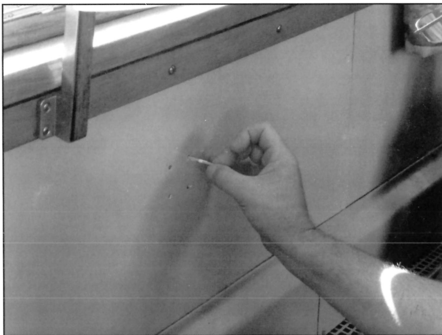
Dan pluggar skruvhål i den bättringsmålade väggen i RCo1.
