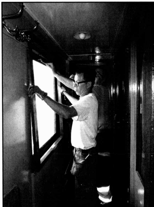
Byte av sönderslaget fönster i Co8cs, cafévagnen. Martin N och Uno i arbe- te.
