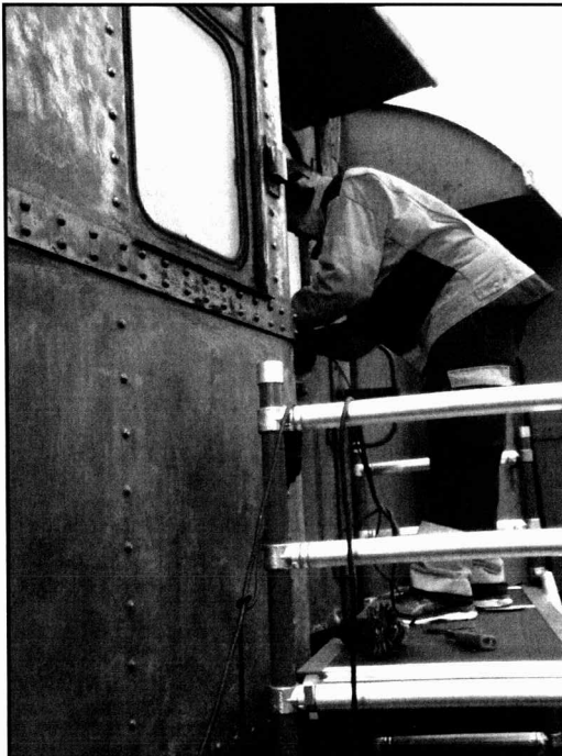
Innan grundmålning slipades vagnsidan av lite lätt. Uno i arbete på södra sidan av RCo1.
