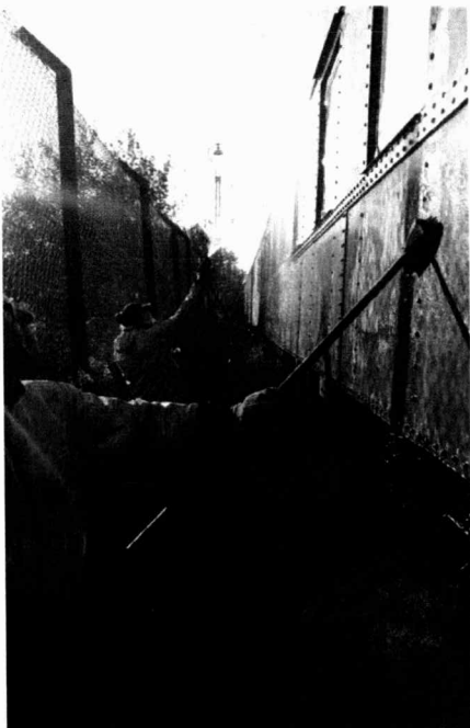
Tvätt av RCo1 före målning.
