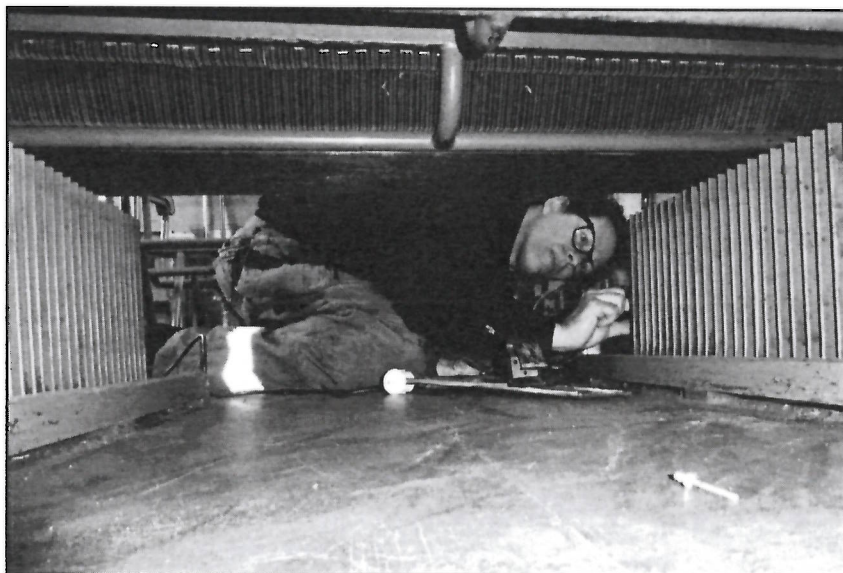
Martin utför elementöversyn i Co8d. Arbetsställningen kanske inte optimal.
