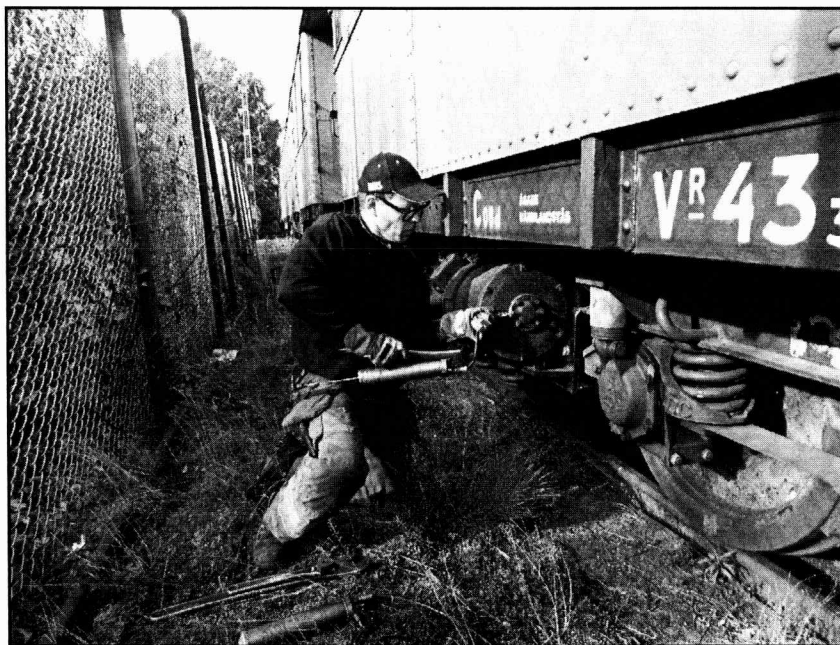
Martin jobbar med tillsyn av sidogeneratorm på Co8d.
