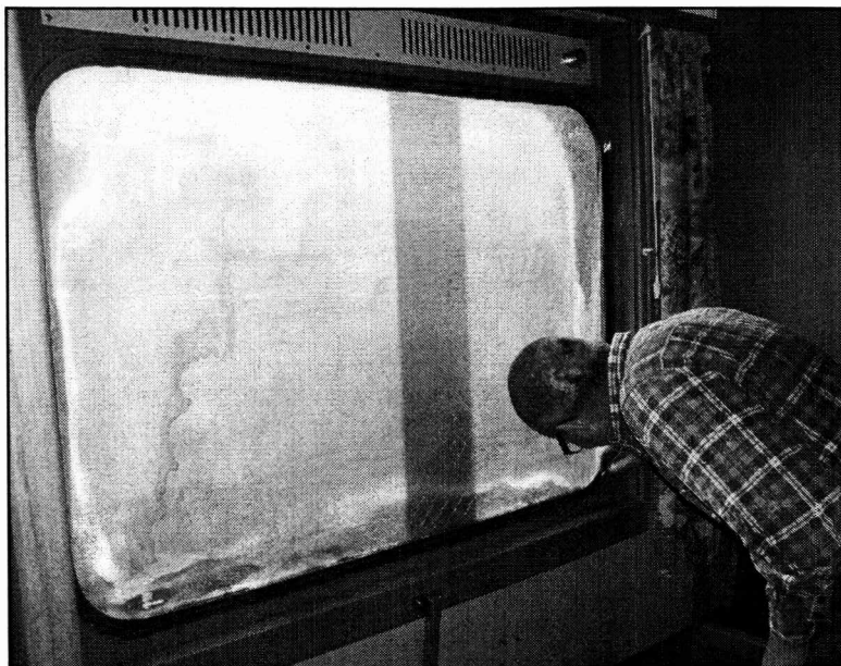
Martin förbereder borttagning av gamla fönstret
