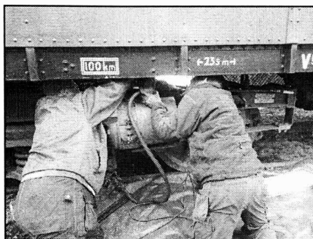
Inkoppling av 24 V kabel till sidogeneratorm. Dan t v och Oscar t h.
