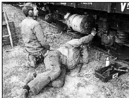
Montering av sidogenerator på Ao 102. Oscar t v och Dan t h.
