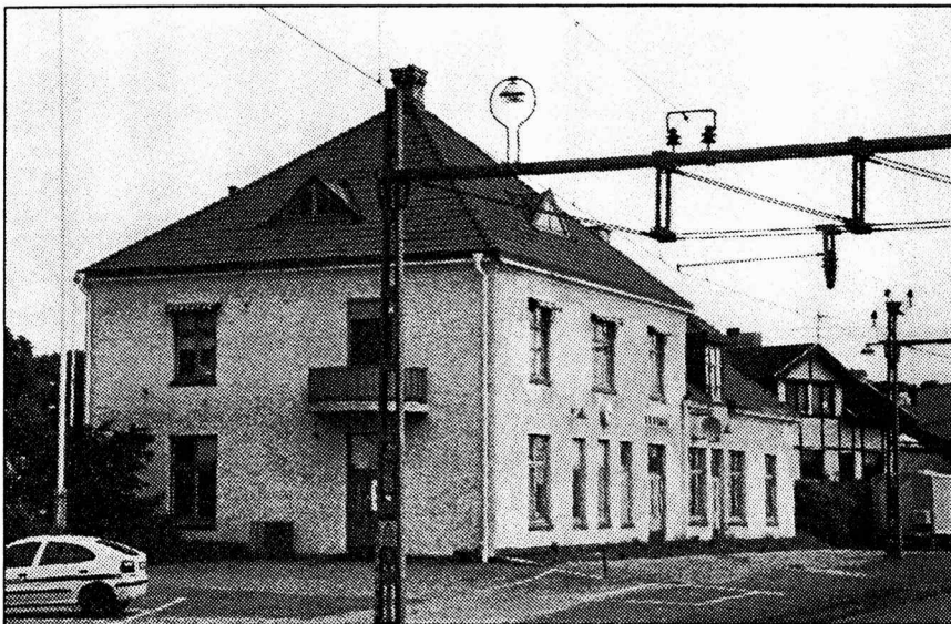
Stationshuset i Lysekil den 16 juni 2001. Foto: David Sohlberg
