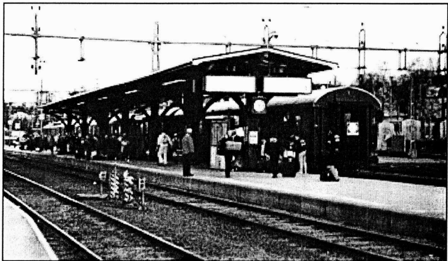
TrainMaint Nords lokomotor Qaz 40-74-944 0045-7 (f.d. SJ Z 18) vid lokstationen i Sundsvall. Lagg märke till att den fått korta "buffertar" för att kunna dra ut en vagn eller ett lok på vändskivan och samtidigt få plats själv. Foto: David Sohlberg
